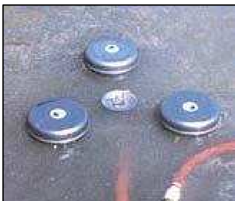
Usuwanie wycieków w zakładzie chemicznym
